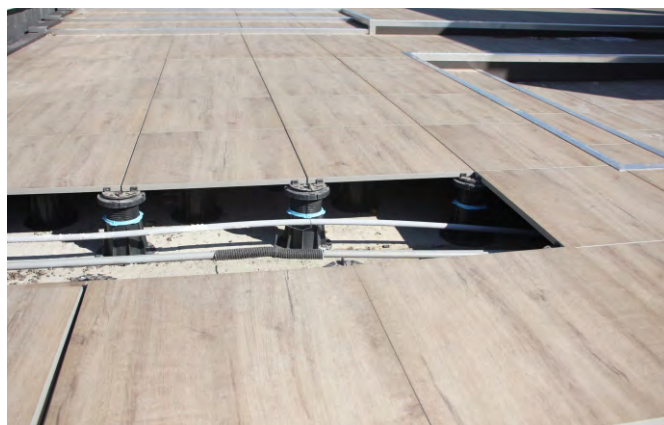
Строительство настилов и полов на эксплуатируемых кровлях.
