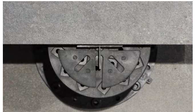
Расположение угла плитки на вершине регулируемой опоры.
