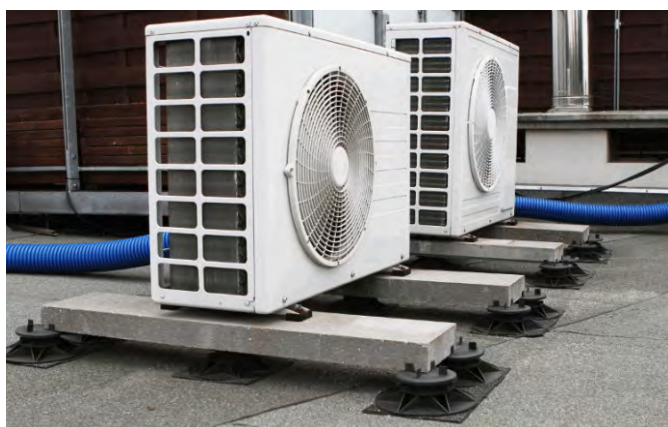
Установка оборудования в строго горизонтальном положении.
